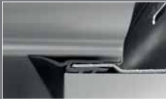
wirkungsvolle Torabdichtung zum Baukörper
