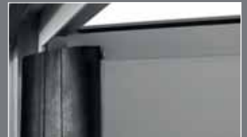
Fingerklemmschutzprofil für Tore mit E-Antrieb
